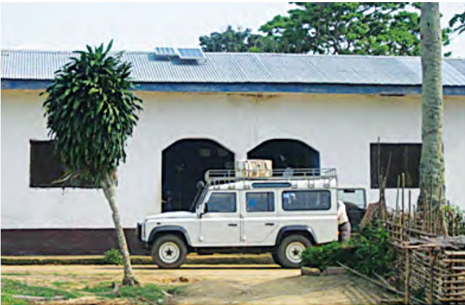
Figure 6. Panneaux solaires installés sur le toit de l'hôpital de Bangumi au nord de la province de Bandundu en RDC. L'énergie produite est utilisée pour faire fonctionner le matériel utilisé pour préparer les échantillons dans le cadre de l'évaluation du kit LAMP pour la THA.
